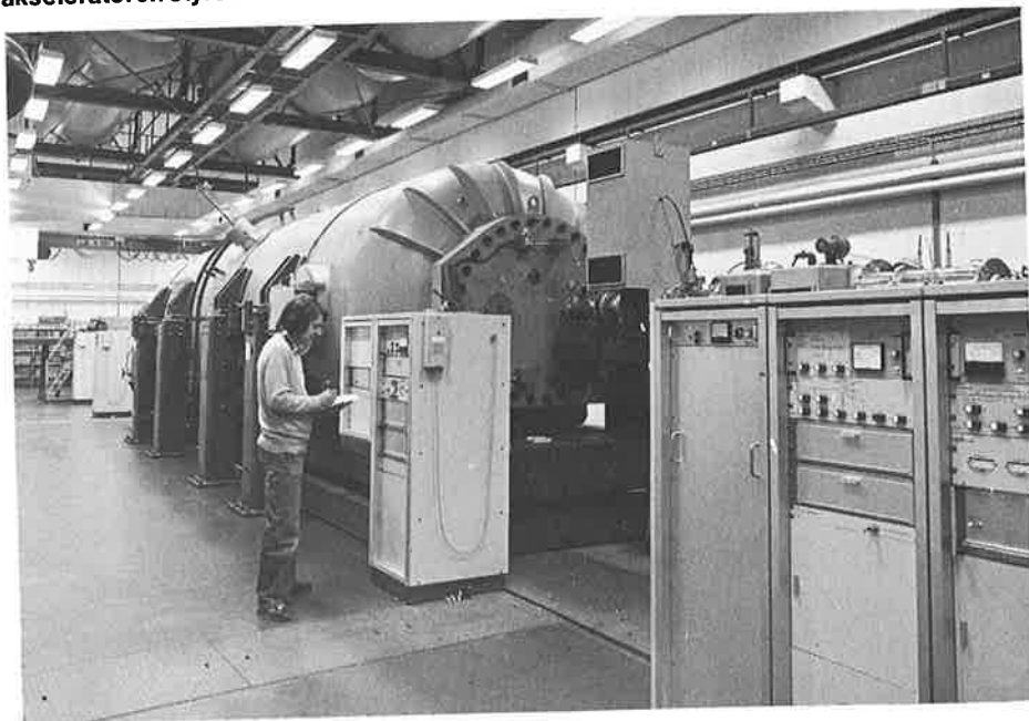
Maskinrommet for tandem-akseleratoren.
