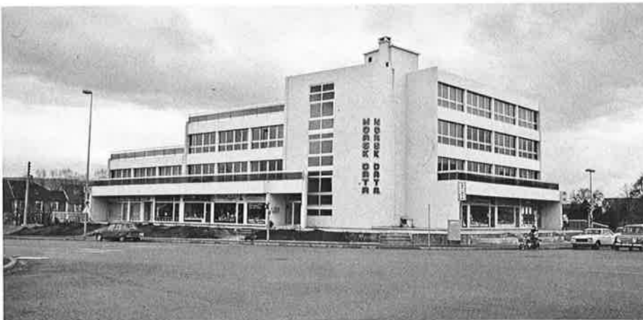
Norsk Data Frankrike holder til i et spesialbygget kontorbygg i Ferney-Voltaires sentrum.
