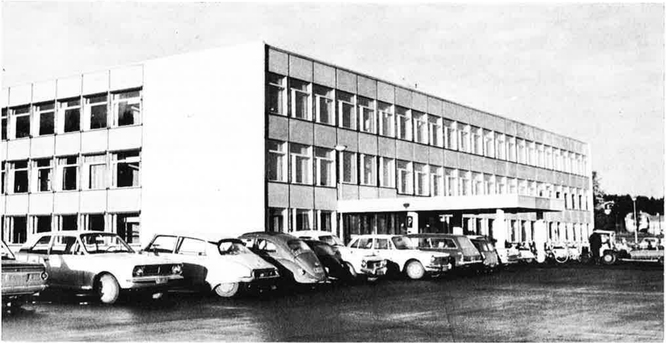
Sørlandet Tekniske Skole, Grimstad. To av elevene opptatt ved en av de 5 teletypeterminaler.
